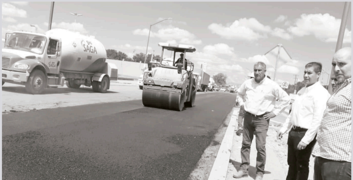
Paco Treviño supervisando la obra de pavimentación.
